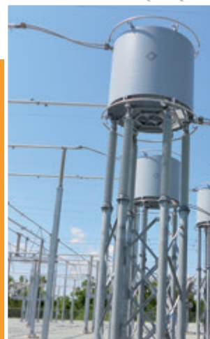
Токоограничивающие реакторы на
