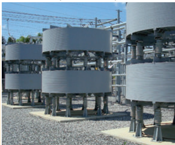
Тиристорно-управляемые реакторы (США)
