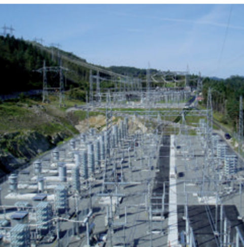
Реактор с фильтром гармоник перем. тока (Норвегия)
