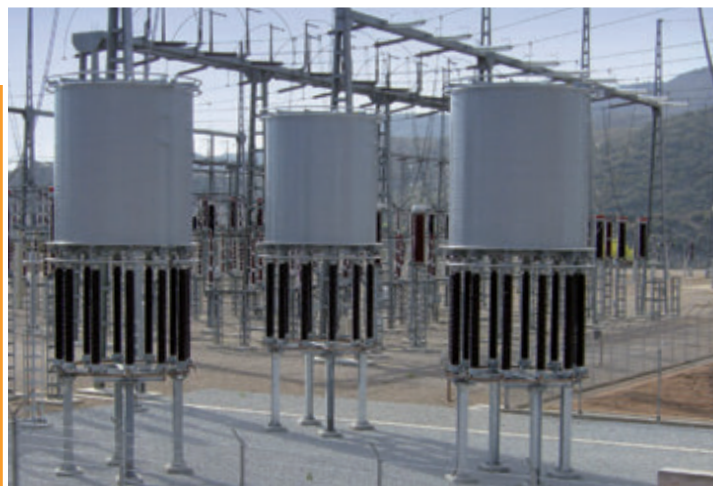
Проточные реакторы на 225 кВ (Португалия)
